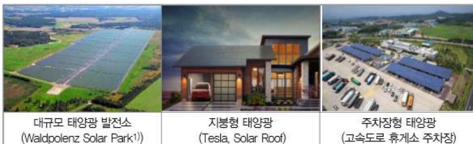
[그림-12] 태양광 발전 설치 사례
